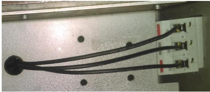
**Figura 26. Conexión de la salida de la protección a la entrada del rectificador**
