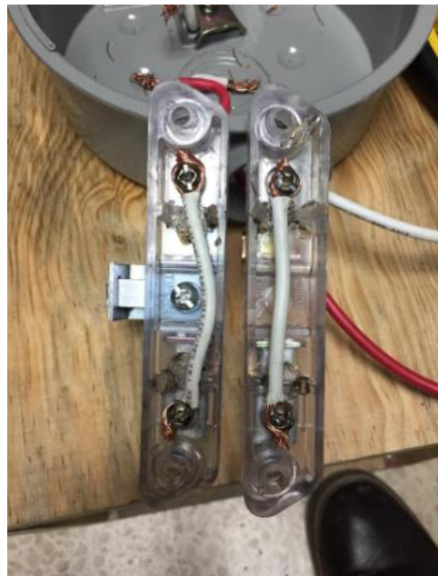
Imagen 31: baquelita transparente con puente en las fases.
