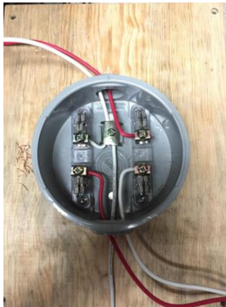
Imagen 26: cambio de fases en la base de medicion.
