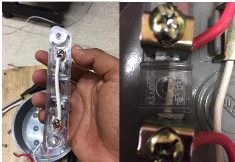
Imagen 23: puente en baquelita transparente en base de medición.
