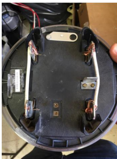
Imagen 27: puente en terminales de medidor con conductor #12.
