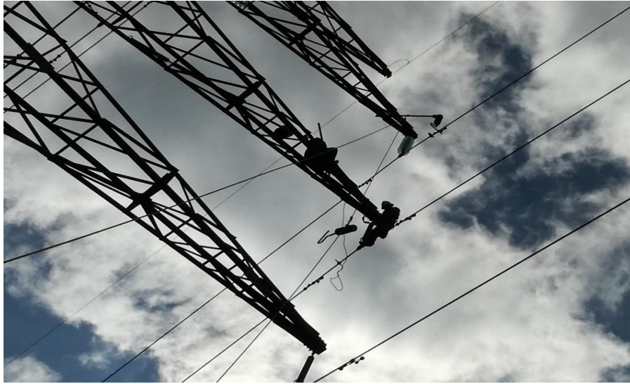
Figura 44.-Instalación de Apartarrayo tipo ALEA, clase 2, en fase “A” y “B” en la línea 73810.
