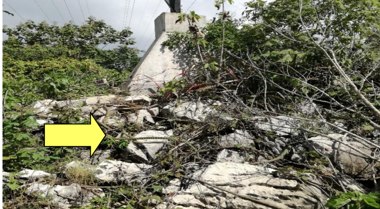
Figura 45.-Se observa tipo de suelo rocoso.
