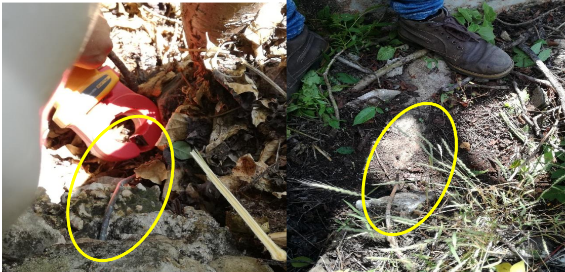
Figura 46.-Evidencia de varillas de tierra enterradas en pata 1, 2 y 4.
