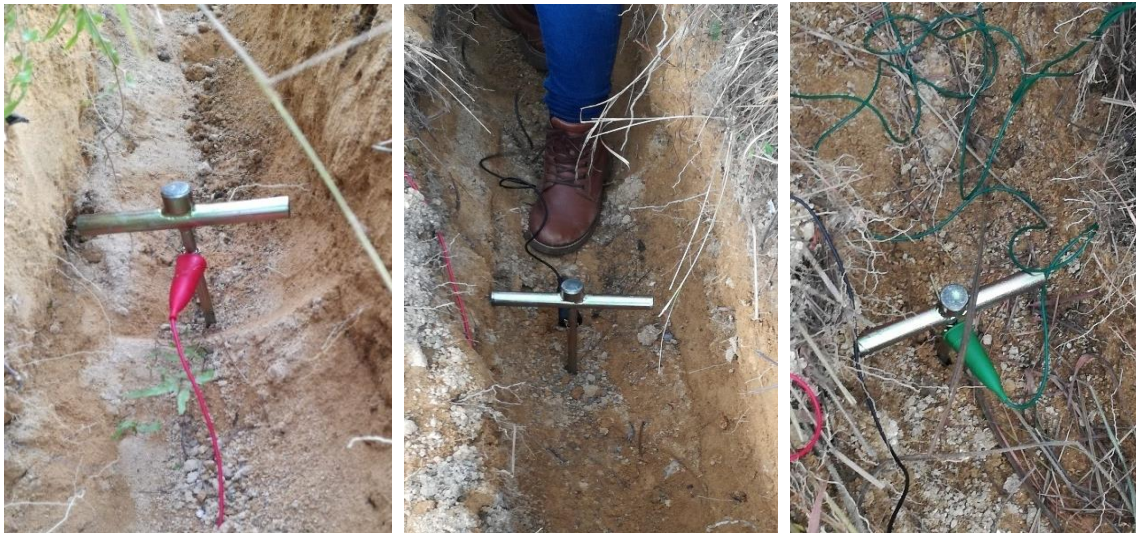
Figura 58.-Instalación de los 4 electrodos para realizar la medición de resistividad del terreno. El principio básico de este método es la inyección de una corriente directa o de baja frecuencia a través de la tierra entre dos electrodos exteriores C1 y C2, mientras que el potencial que aparece se mide entre dos electrodos interiores P1 y P2, en la primera medición se obtuvo una lectura del terrometro en ohms siendo de 38.5 \Omega , la distancia entre electrodos fue de 3 metros y la profundidad de enterrado de los electrodos fue de 0.15 metros.
