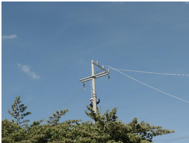
Fig. 3.2.10 Instalación de cable AAC y cable múltiple 2+1 AL
