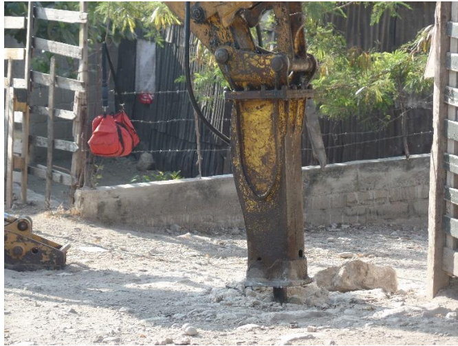
Fig. 3.2.2 Realización de cepas con maquinaria pesada
