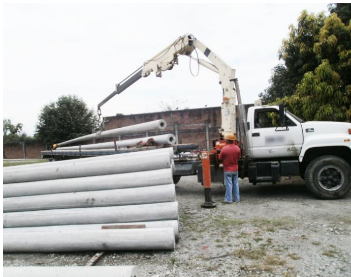
Fig. 3.2.4 Recibiendo los postes de la bodega de CFE
