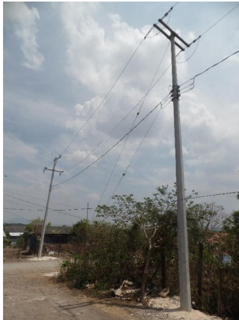
Fig. 4.1 Línea aérea M.T y B.T terminada
