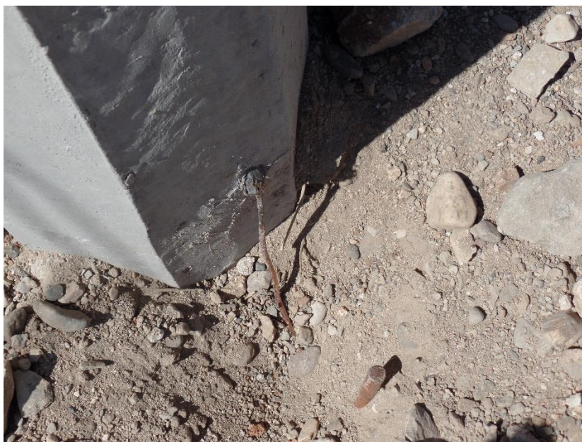
Fig. 3.2.11 Electrodo de tierra correctamente instalado
