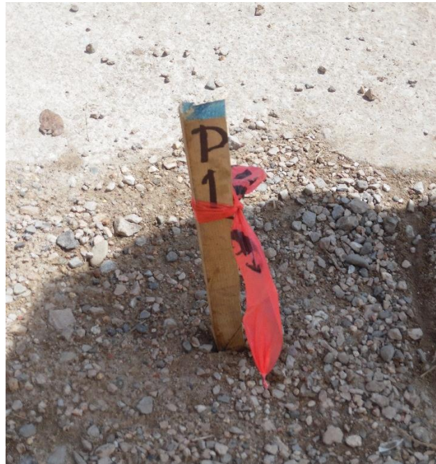
Fig. 3.2.1 Estacas para la realización de cepas
