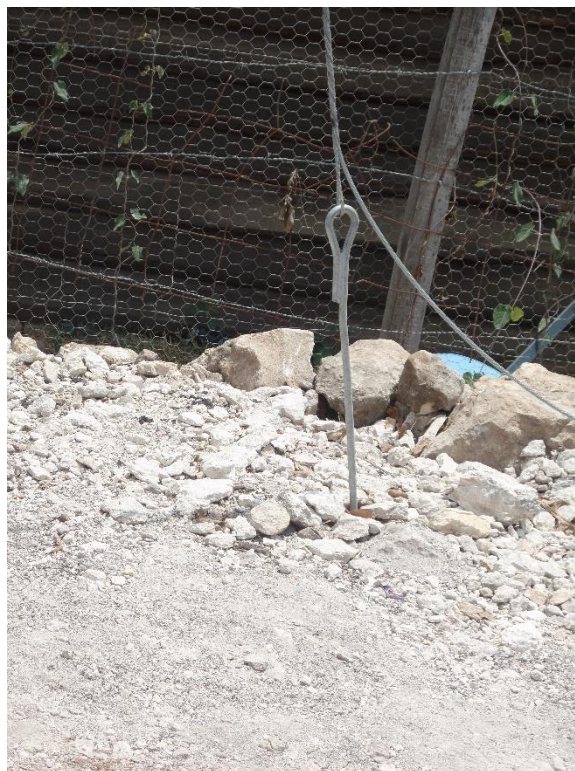
Fig. 3.2.9 Instalación de retenida
