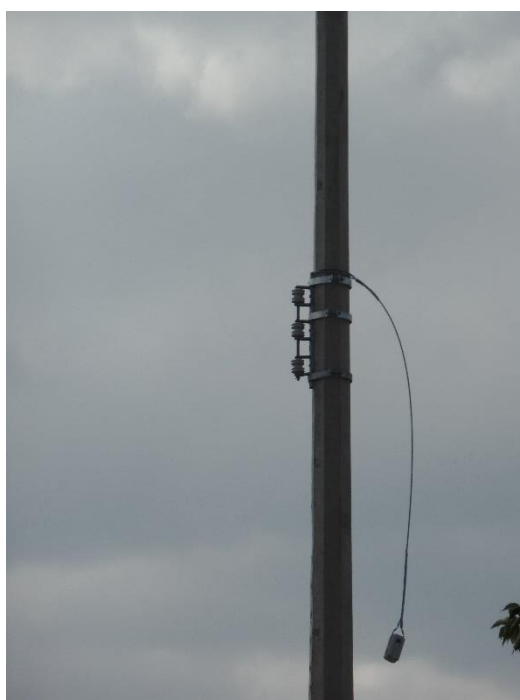
Fig. 3.2.8 Instalación de estructuras en Baja Tensión
