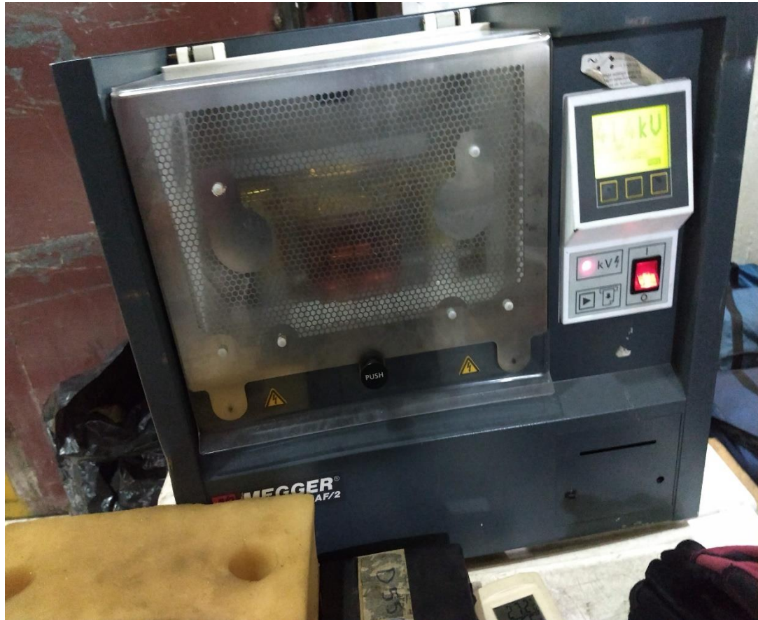
Imagen 8 Aparato que realiza pruebas de rigidez dieléctrica al aceite de transformador de potencia 225 MVA
