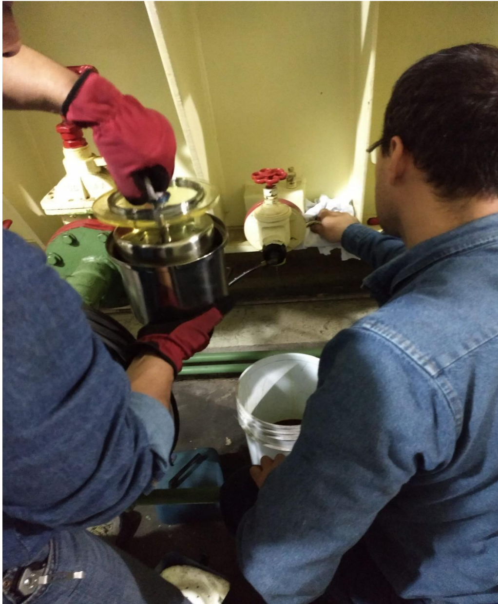
Imagen 10 Extracción del aceite del transformador de potencia
