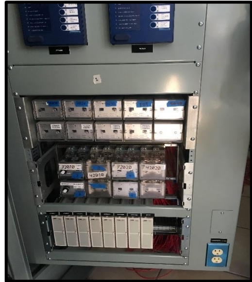
Figura 9.1 Armado de circuitos para simulación apertura y cierre de interruptores a través de relevadores biestables ASEA
