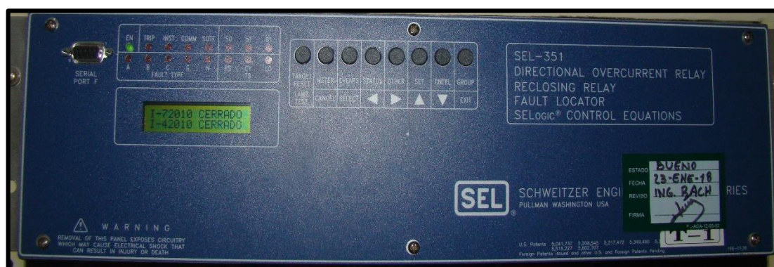
PRT1(protección de respaldo de transformador) del interruptor 72010H y 42010L.Relevador SEL – 351 protección de sobrecorriente
