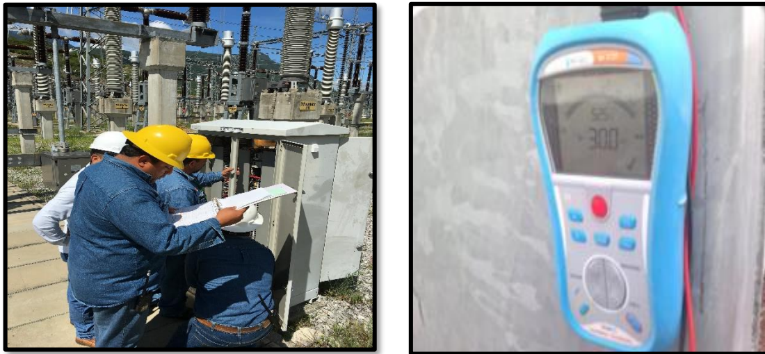
Figura 6. Tendido y pruebas al cable de control
