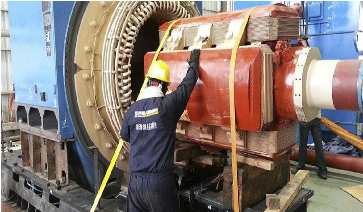
Figura 2. Colocación del rotor de polos salientes en el estator
