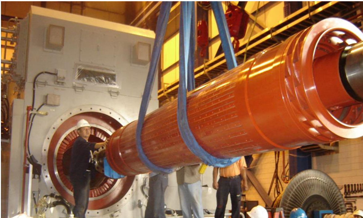
Figura 1. Colocación del rotor de polos lisos en el estator. Empresa GENERMEX
