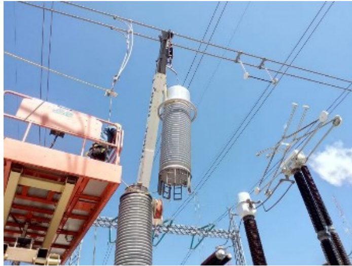
Figura 3.2.7 Primera parte del TPI quitado, listo para ser ubicado en camión
