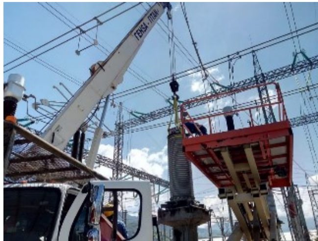
Figura 3.2.8 En la imagen se observa cómo se sujeta el TPI a la grúa
