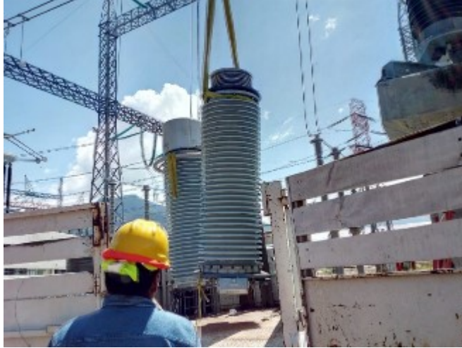
Figura 3.2.9 Colocación del TPI en dos partes sobre el camión
