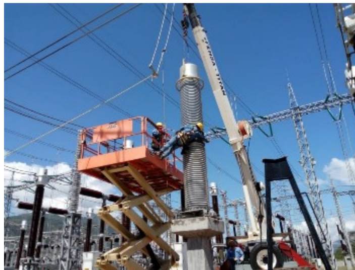
Figura3.2.6 Se observa cómo se quitan los tornillos en la parte de en medio del TPI.
