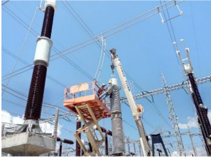
Figura 3.2.5 Colocación de eslinga de carga en la parte superior del TPI
