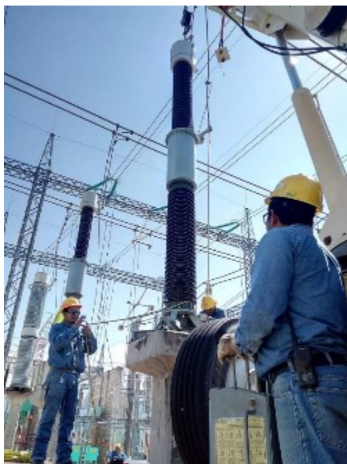
Figura 3.2.13 Comunicación entre el operador de grúa y el eléctrico.
