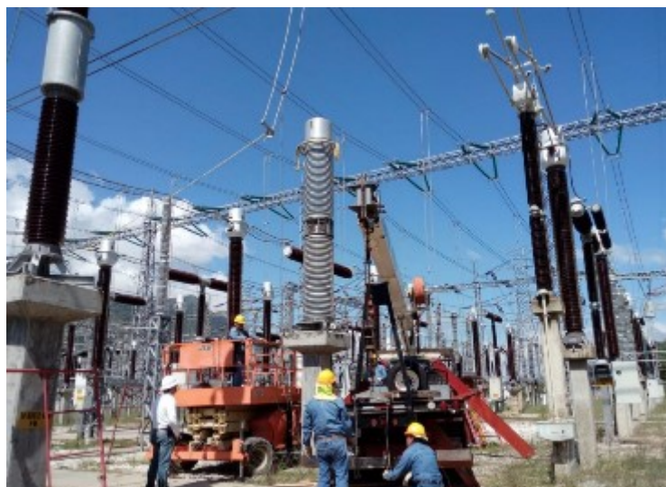
Figura 3.2.4 Desconexión del lado secundario del TPI
