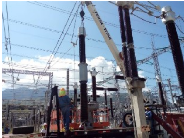
Figura 3.2.12 Posición totalmente vertical del TPI nuevo.
