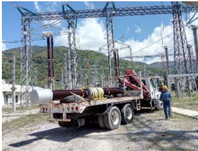
Figura 3.2.10 Desplazamiento de TPI nuevo a sitio
