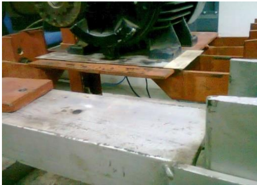
Figura 111.-Nivelacion del motor.
