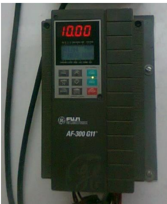
Figura 138.- Variador de frecuencias 10 Hz. Prueba 2.
