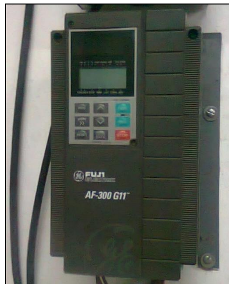
Figura 125.-Variador de frecuencias.
