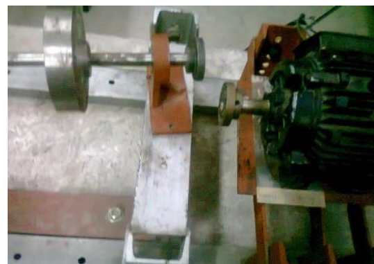
Figura 112.-Colocacion de láminas en los soportes del motor.
