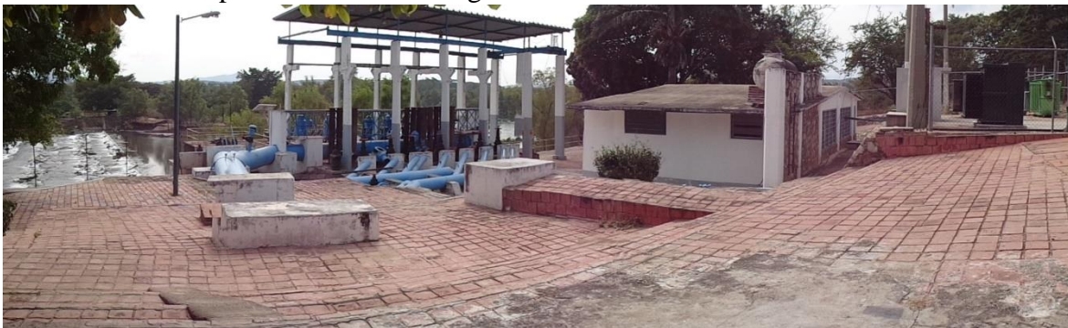
Ilustración 1- planta captación Santo Domingo
