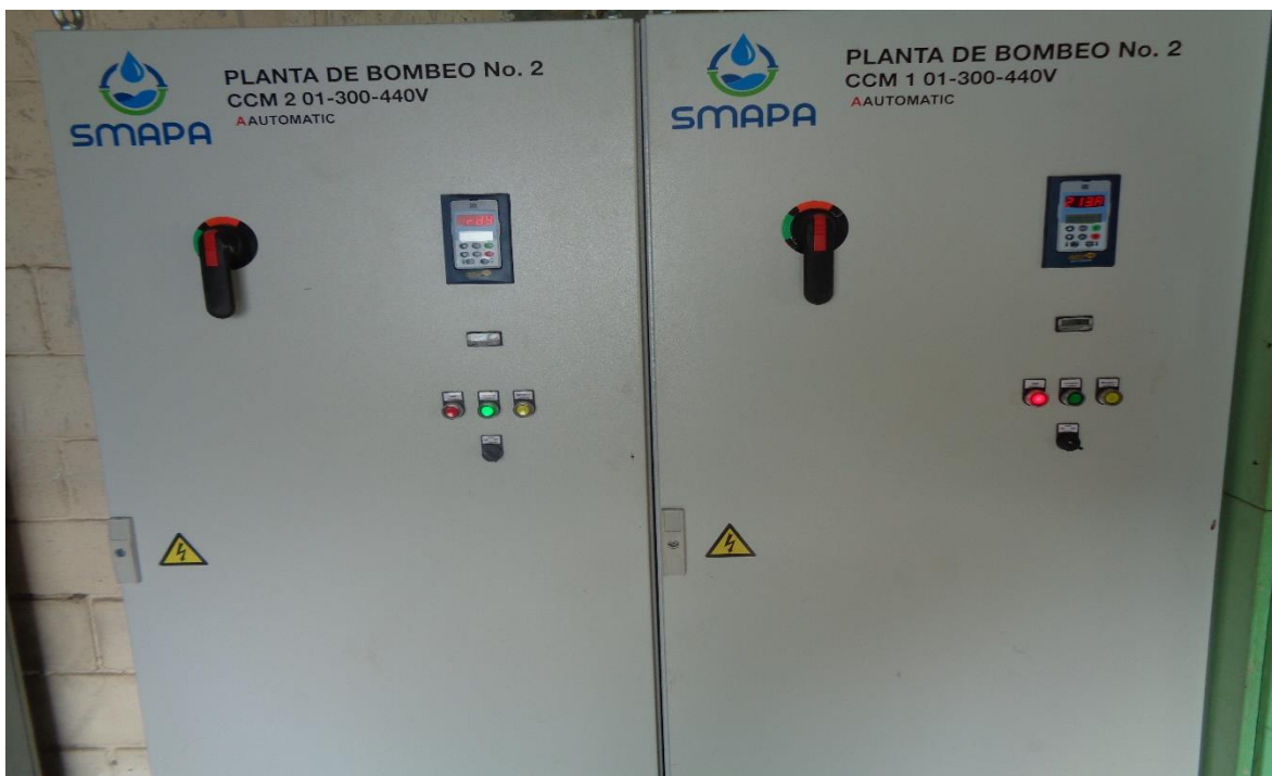
Ilustración 18- Arrancadores de estado solido
