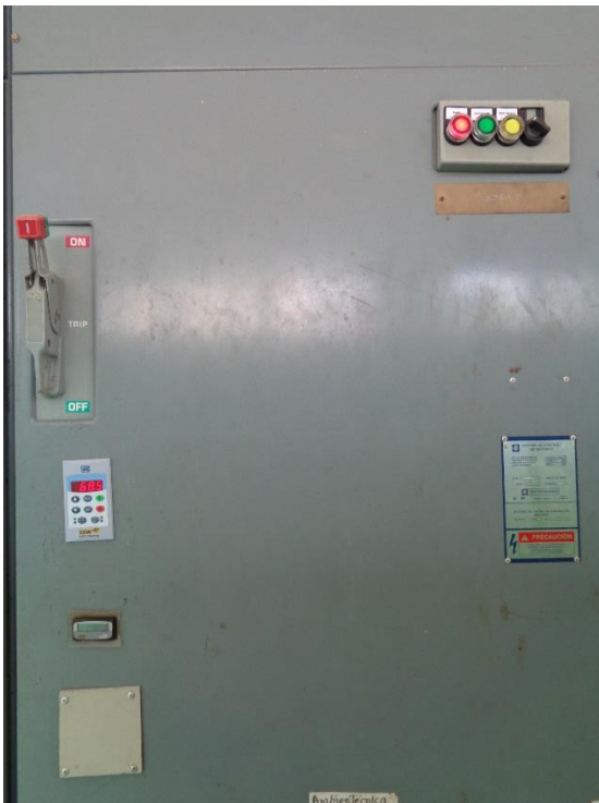
Ilustración 3- Arrancador acoplado en cabina anterior
