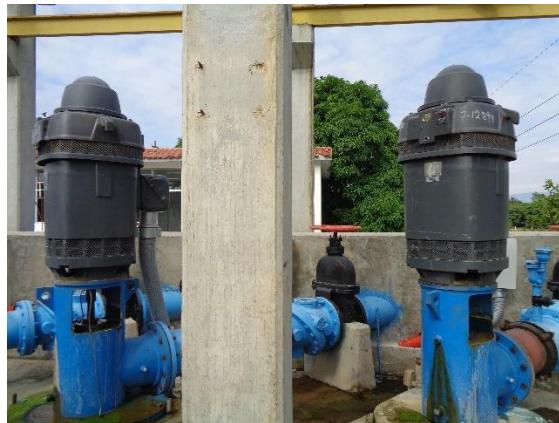
Ilustración 14- Motores verticales nuevos
