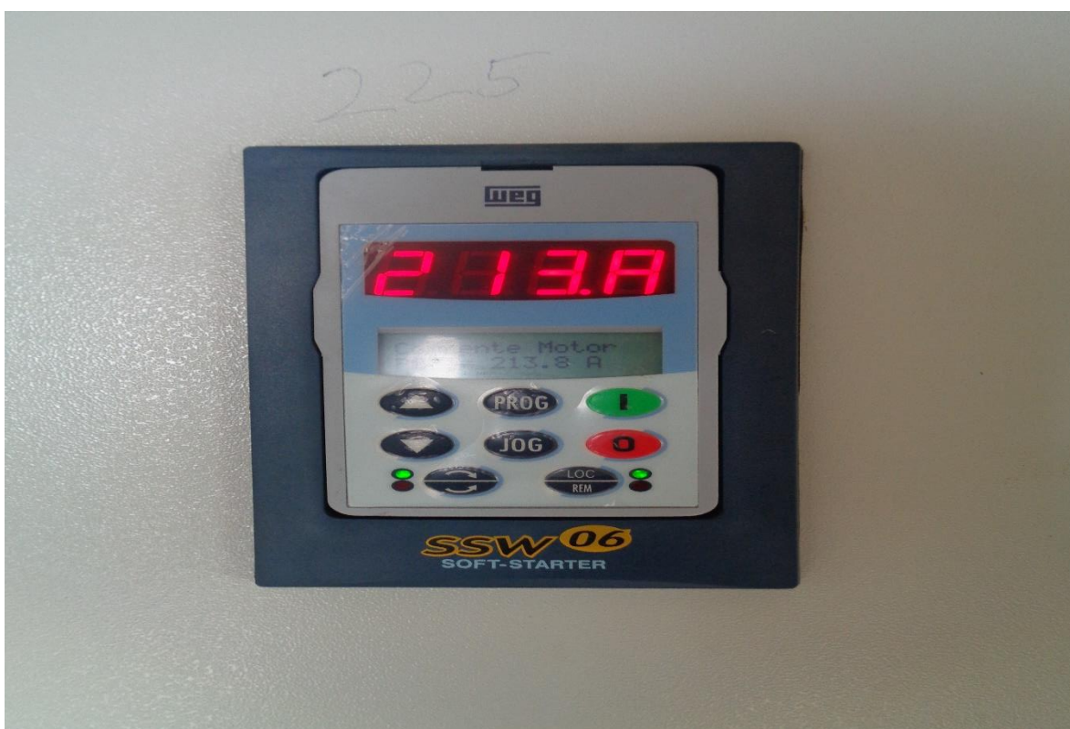
Ilustración 19- Lector de arrancador para obtener diversos datos de operación
