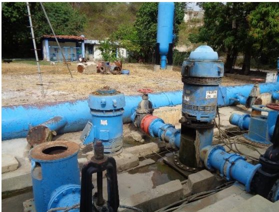
Ilustración 29- Motores verticales antiguos
