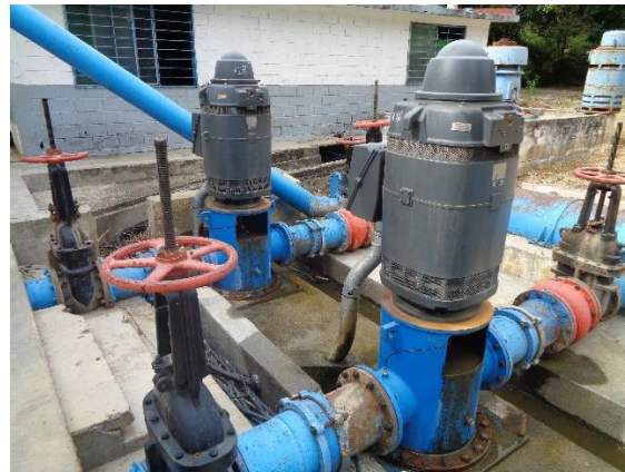
Ilustración 30- Motores verticales nuevos
