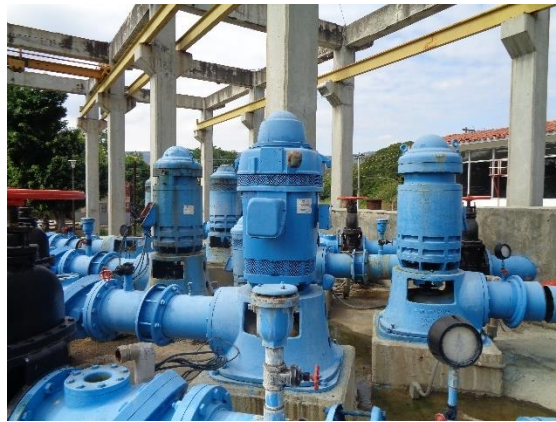
Ilustración 13- Motores verticales antiguos
