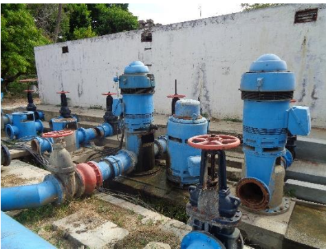
Ilustración 21- Motores verticales antiguos
