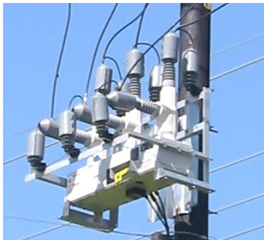
Fig 2.5. Restaurador con aislamiento al vacío.
