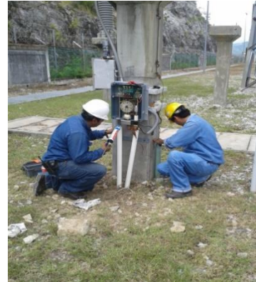
FIGURA 4. 21 CAMBIO DE PVC PARA SEGURIDAD DEL CABLE RF
