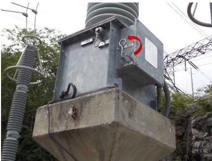
FIGURA 4. 18 SE ATERRIZA MIENTO DE LAS 2 FASES
