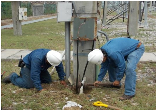
FIGURA 4. 21 CAMBIO DE PVC PARA SEGURIDAD DEL CABLE RF
