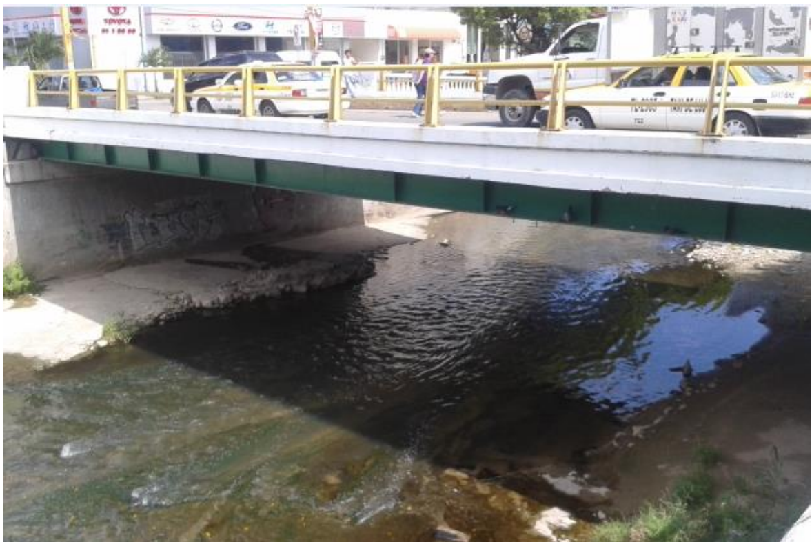
Figura 22. Imagen altura (6° Poniente Norte)
