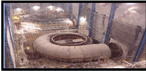
Fig.A2 Carcasa espiral.
