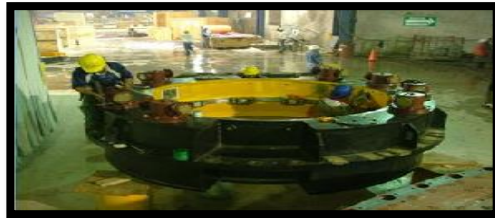
Fig.10 Chumacera guía turbina.
