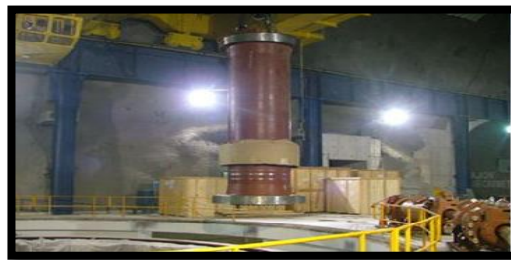
Fig.A6 Flecha de turbina.
