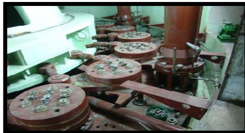
Fig.A14 Mecanismos de regulación.
