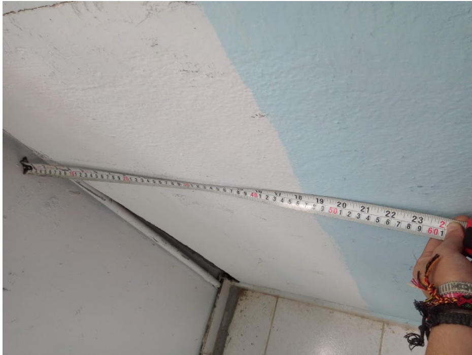
Figura 3.13: Medición del área de operación del rack.
