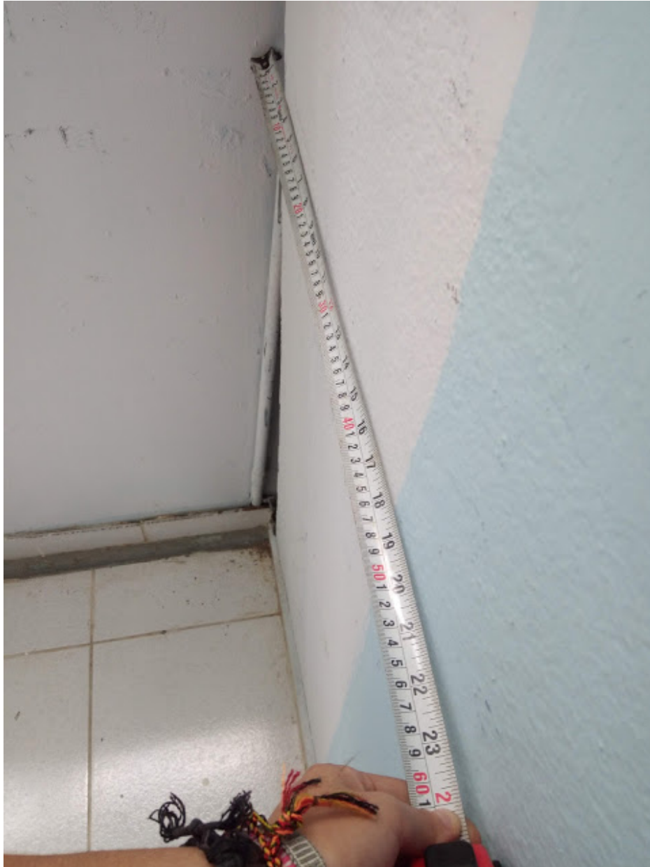
Figura 3.12: Medición del área de operación del rack.
