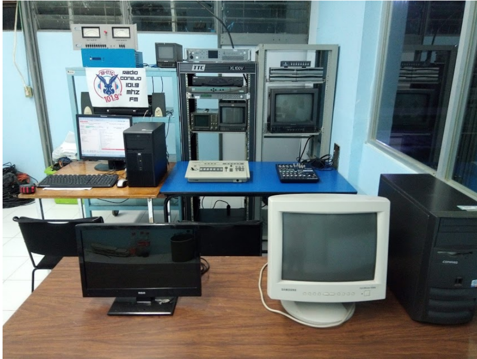
Figura 3.19: Establecimiento de los equipos (área técnica).
