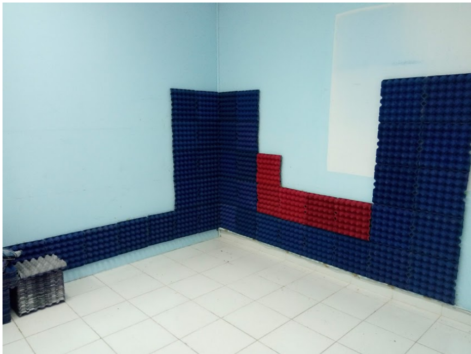
Figura 3.53: Proceso de recubrimiento.
