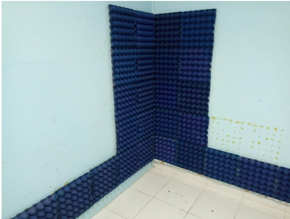
Figura 3.52: Proceso de recubrimiento.
