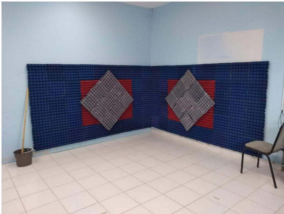
Figura 3.56: Proceso de recubrimiento.
