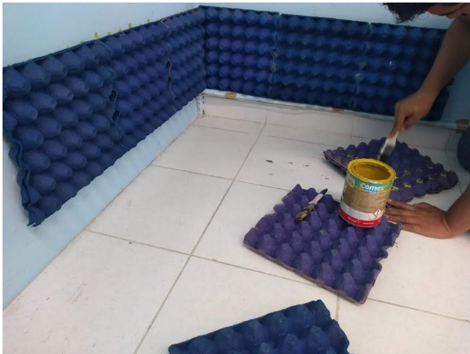
Figura 3.51: Proceso de recubrimiento.
