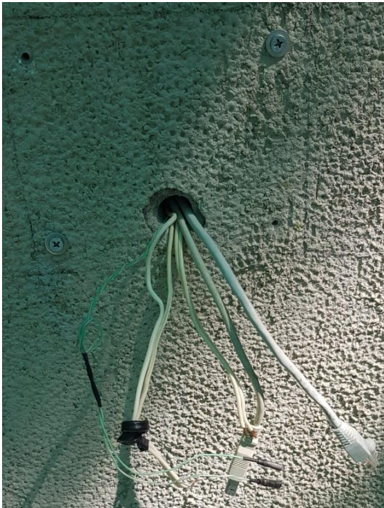
Cableado para próximo empotramiento del dispositivo
