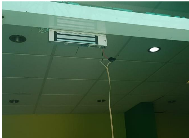
Fijado de la chapa magnética y pruebas de alimentación
