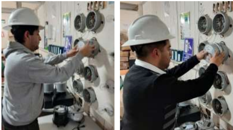
Fig. V, Colocación de Medidores
