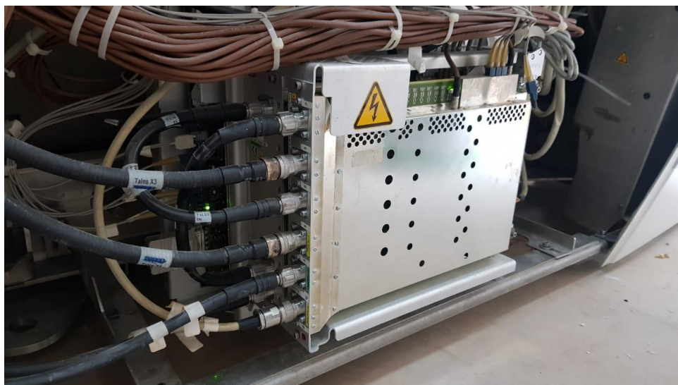
Acercamiento de la imagen anterior para mejor apreciación de la estructura del módulo.
