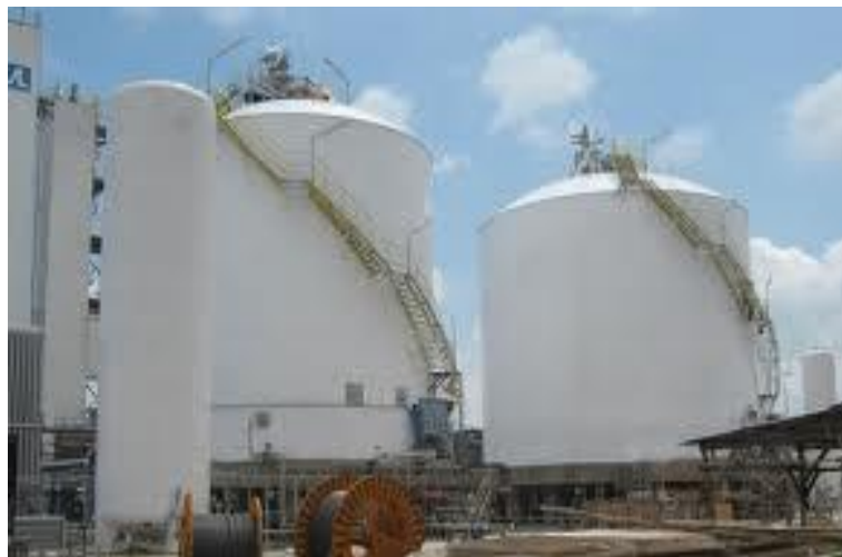
Figura: 1 Tanques de almacenamiento de líquidos
