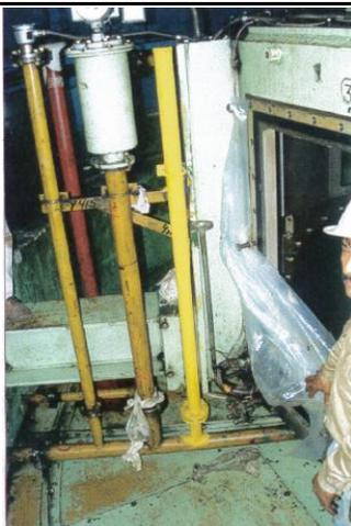
Detector de nivel de aceite a flotador.
