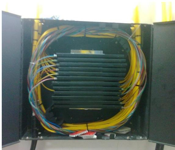
Fig. 1 - Este es un baúl abierto que muestra los buffers de una parte del HOB.
