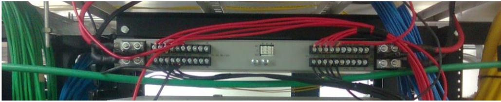
Fig. 33 - Panel de fusible parte de atrás.
