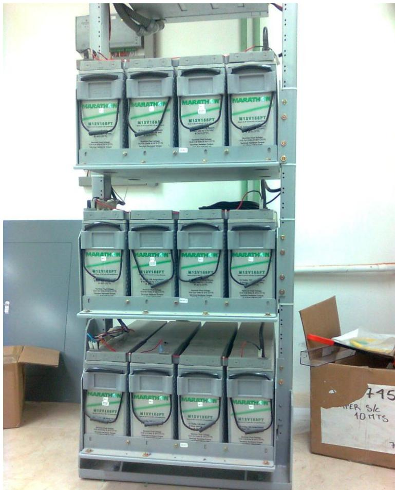
Fig. 59 - Banco de baterías de la planta de DC.
