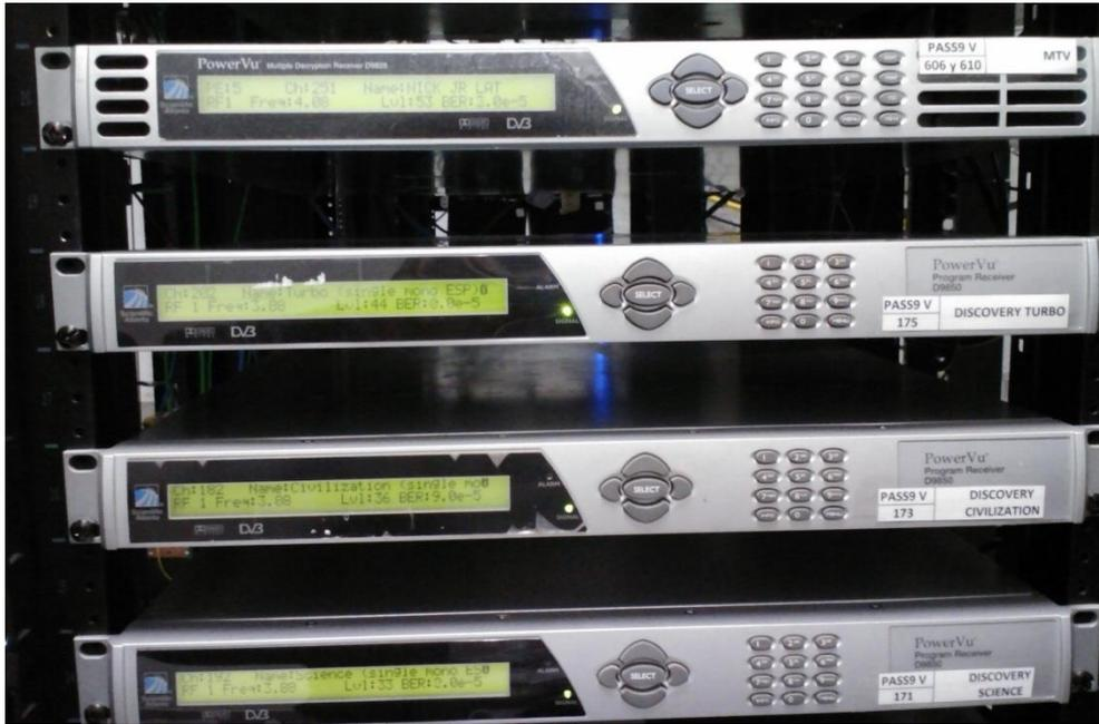
Fig. 55 - Receptores de audio y video de canales ubicados en el CTC.
