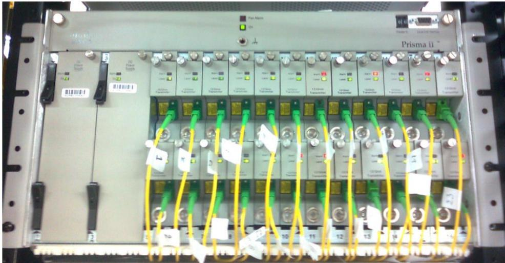
Fig. 16 - Chasis con sus elementos correspondientes, algunos con el nivel balanceado, podemos ver que hay algunos transmisores alarmados.
