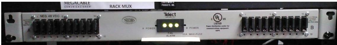
Fig. 29 - Panel de fusible con sus diez switches en uso. Los fusibles que comúnmente se usan en el HOB son de 15 Amperes.
