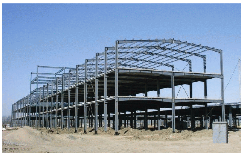
Fig 2.1 Estructura de acero
