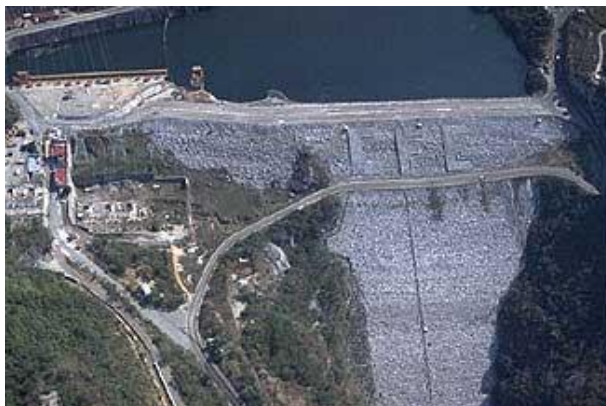
Fig. 1.1 Central Hidroeléctrica Manuel Moreno Torres
