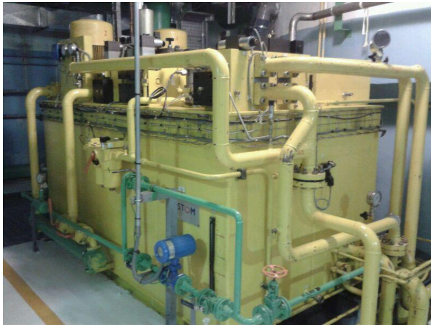
Imagen 1.3. Depósito de aceite del sistema de regulación 2ª etapa.
