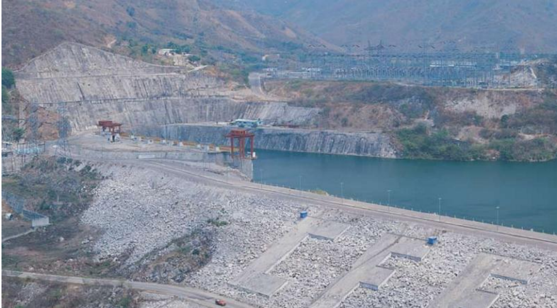
Imagen 1.1. Fotografía de la cortina de la Central Hidroeléctrica Manuel Moreno Torres.
