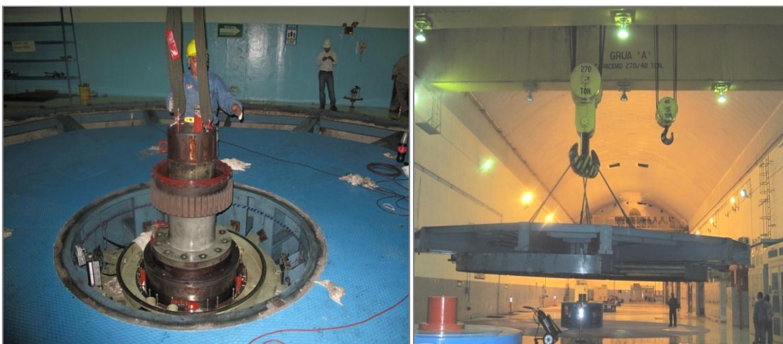
Imagen 3.1. Fotografías del desmontaje de flecha de anillos rozantes y del soporte de la chumacera guía generador.
