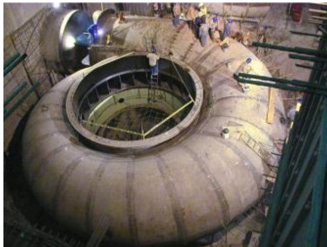
Imagen 2.1. Fotografía de una carcasa espiral.
