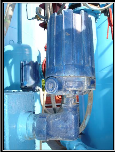
Img. 3.23 Sensor de nivel con switch de mercurio
