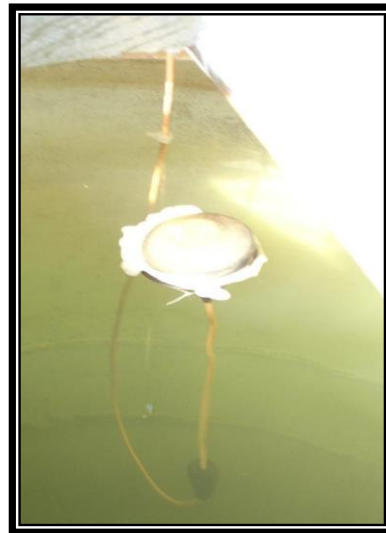
Img. 3.11 Sensor de nivel (tipo pera)
