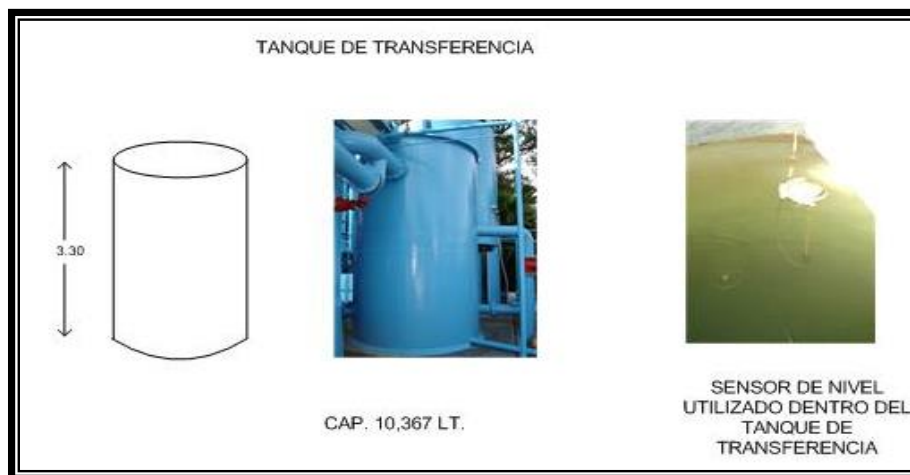
Fig. 3.5 Tanque de transferencia y sensor de nivel tipo pera
