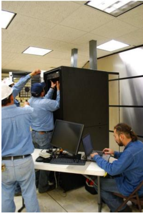
Fig. 3.2 instalación del gabinete del D400
