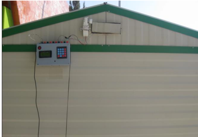
Figura 47: Colocación del sistema en la parte lateral de la Deshidratadora
