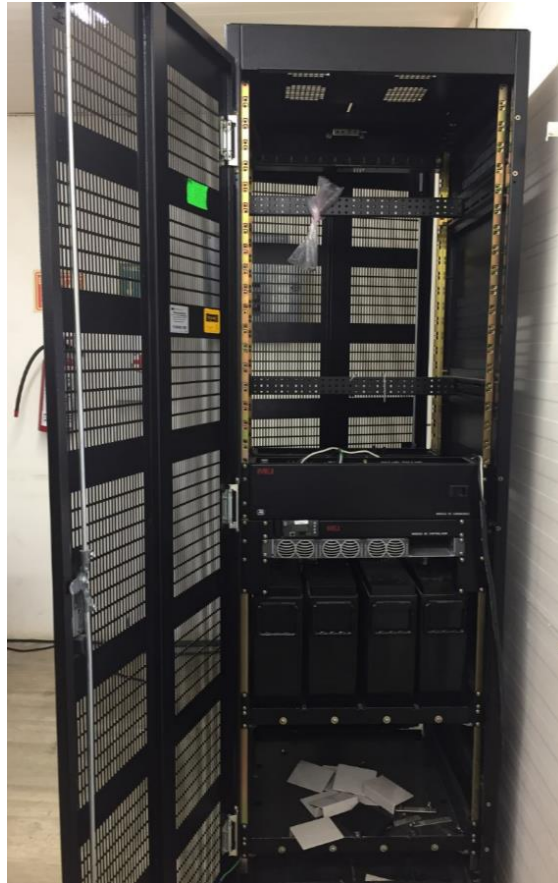
Ilustración 11. Sistema de Fuerza de 48 VCD.
