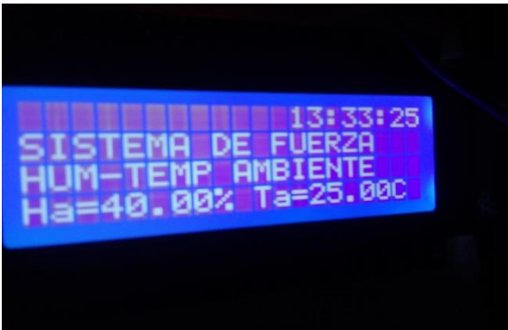
Figura 3.33 Medición de Humedad y Temperatura
