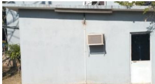
Imagen 3.21 Caseta del repetidor coapilla
