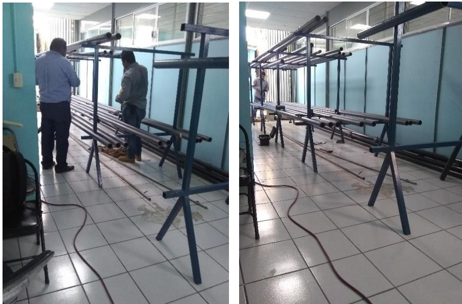
Figura 26. Armado de la planta piloto
