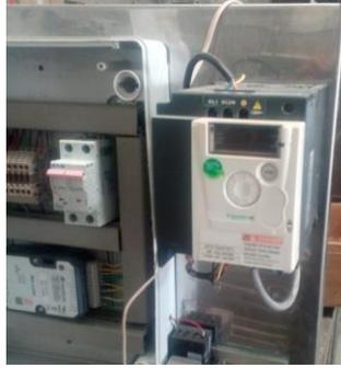
Figura 26. Montaje final de Inversor de Frecuencia
