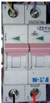
Figura 34. – Interruptor Encendido
