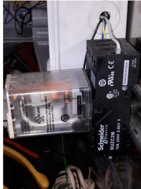
Figura 24. Conexionado Relevador de Potencia para Motor
