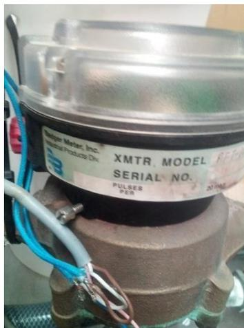
Figura 21. Montaje de Transmisor Badger Meter
