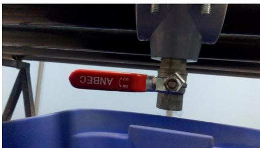
Figura 3.1 Válvula manual desactivada.
