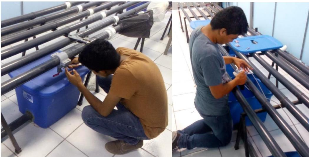
Figura 3.14 Sustitución de las válvulas mecánicas por electroválvulas
