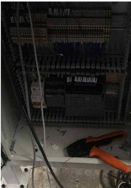
*Ilustración 17. Panel U611 en construcción.*
