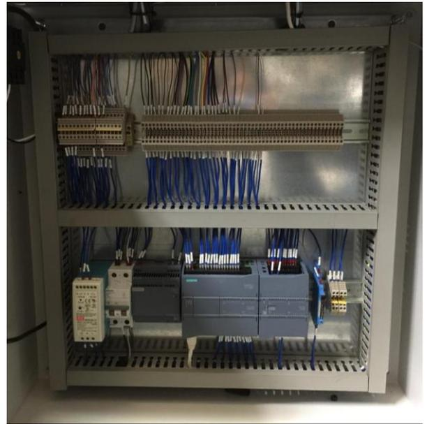
*Ilustración 110. Cableado final U611.*
