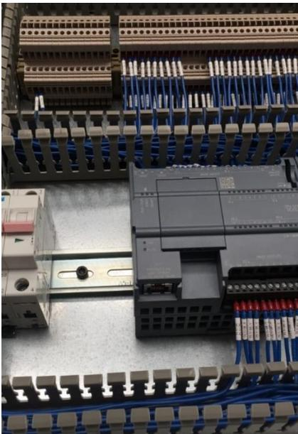
*Ilustración 16. Conexión del panel a sensores y actuadores.*
