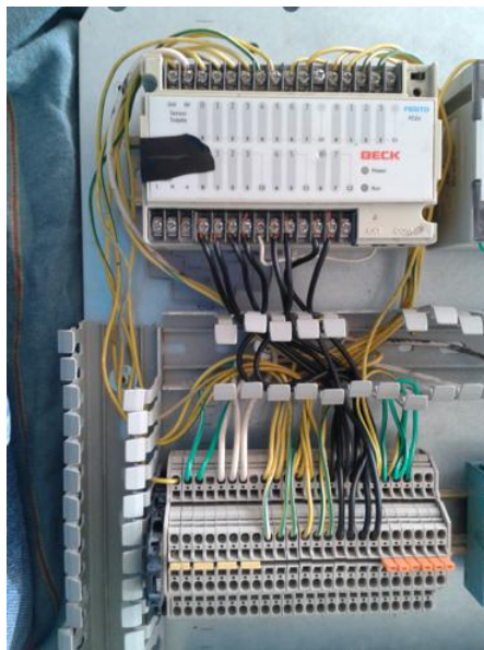
Figura 4.28: Acercamiento del PLC
