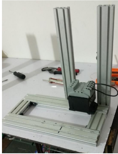
Fig. 3.13 Montaje del transformador en la estructura del tablero
