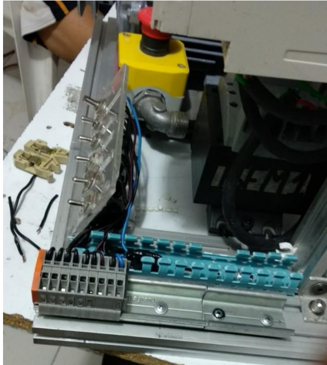
Fig. 3.19 Montaje de clemas de conexión y canaleta sobre la estructura
