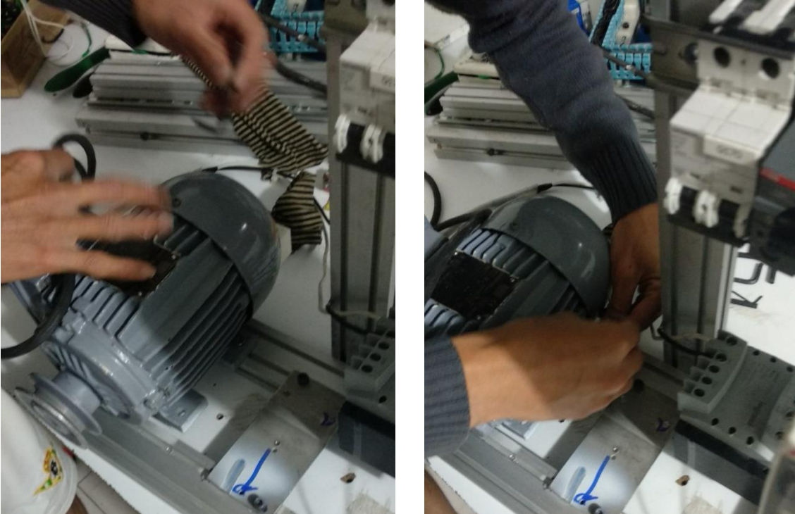
Fig. 3.16 Montaje del motor weg sobre la estructura
