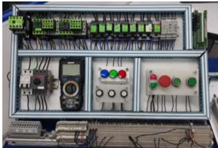
Fig. 3.32 Tablero Control Neumático
