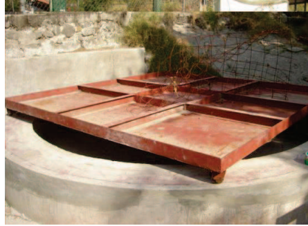
Figura A-1 Estructura para la losa-piso.
