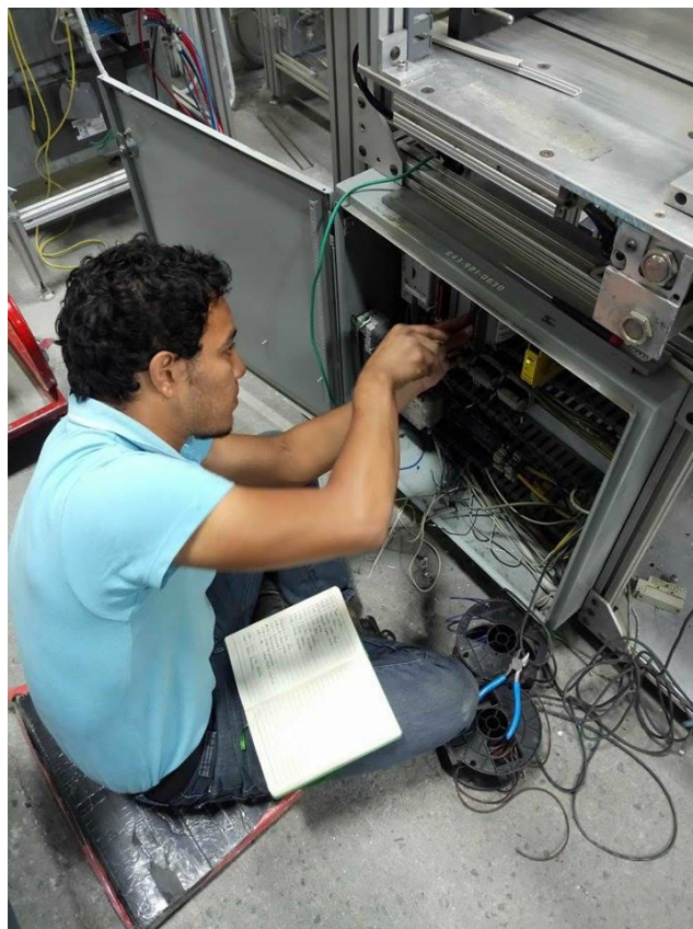
Fig. 43 conectando y ordenando las conexiones
