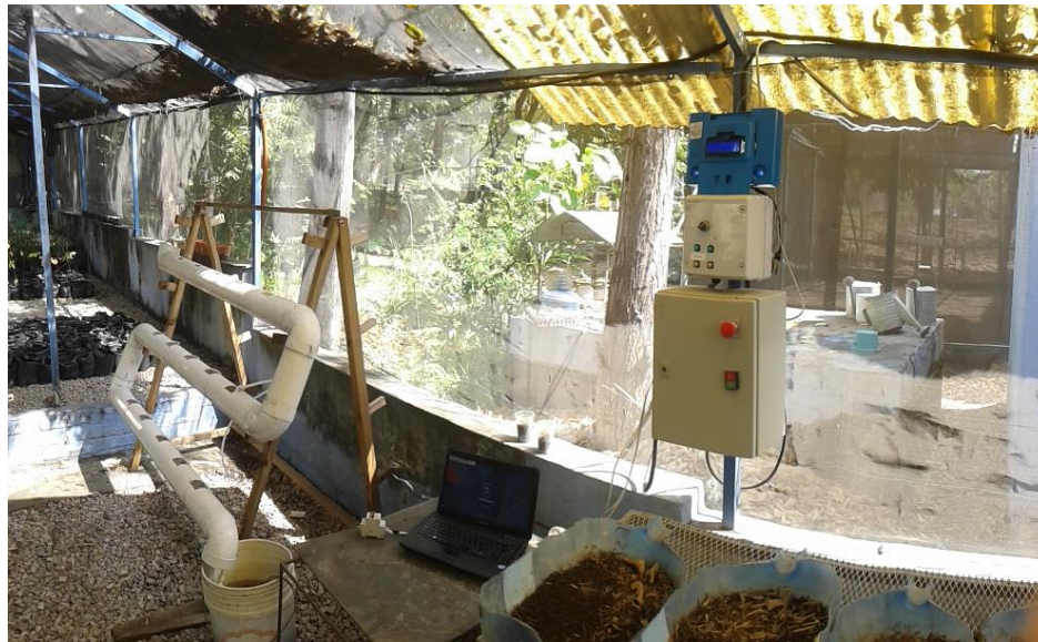
Figura 3.42 Prueba de la estación meteorológica instalada en el invernadero
