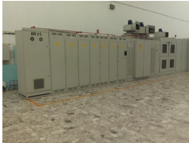
Fig. 27 Regulador Automático de voltaje AVR marca SEPAC.
