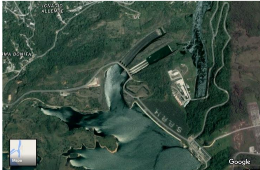
Fig. 3 Vista satelital C.H. Malpaso, google maps
