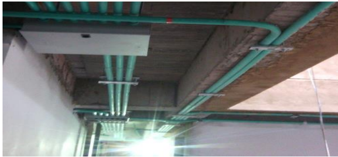
Fig. 18 Instalación de tuberías
