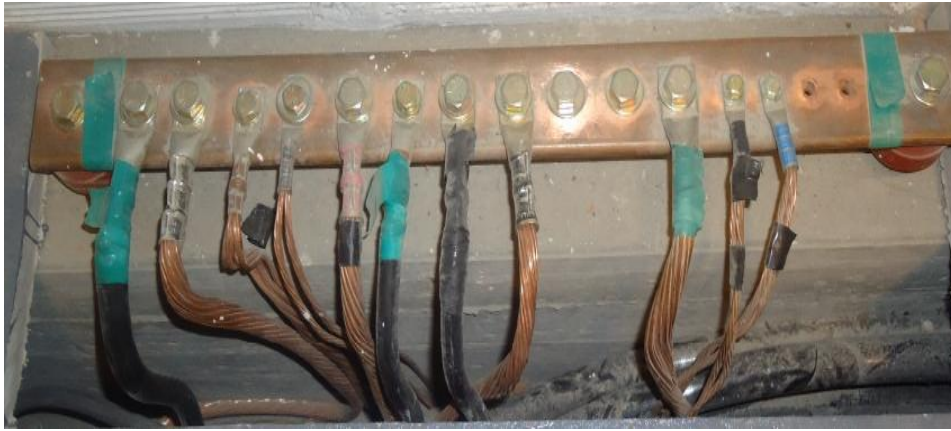
Fig. 42 Sistema de tierra
