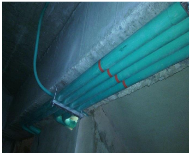
Fig. 19 Instalación de tuberías
