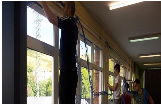
Fig. 25 cableado por canaletas
