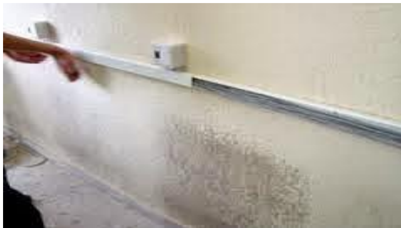
Fig. 24 cableado por canaletas
