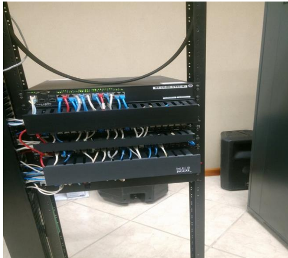
Fig. 43 Instalación de switch
