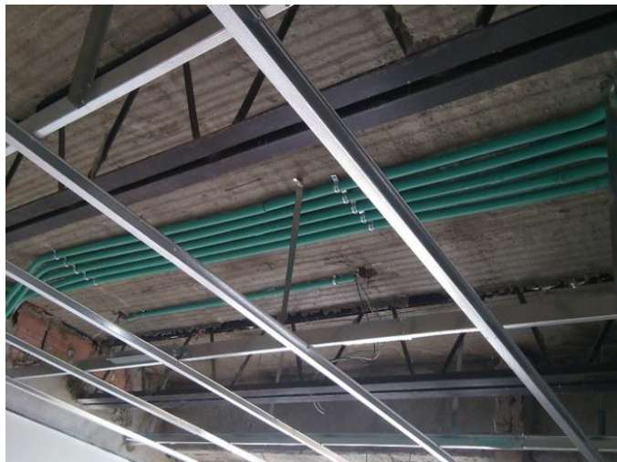
Fig. 20 Instalación de tuberías
