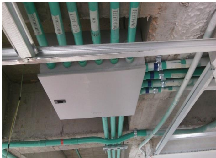
Fig. 21 Instalación de tuberías
