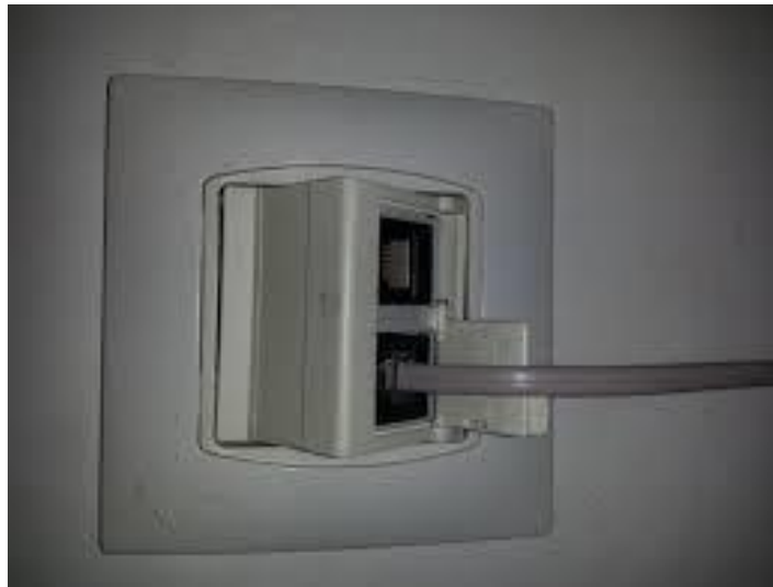
Fig. 33 Colocación de salidas de Ethernet funcionando
