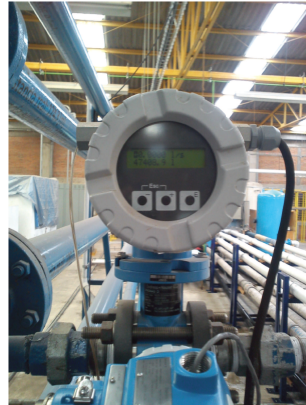
Figura 5: Sensor de flujo Promag 10D
