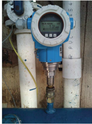
Figura 7: Sensor de presión Cerabar PMP71
