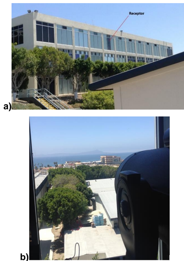
Figura 59. Vista interior a) y exterior b) del lugar donde se instaló el receptor.
