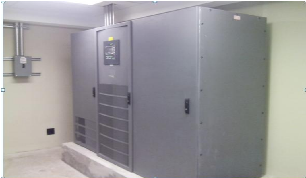
Figura 3.4- Colocación del modelo SG- 150
