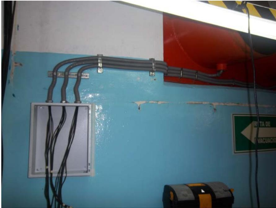
**FIG.4.8.1 Colocación del gabinete de salida del generador**
