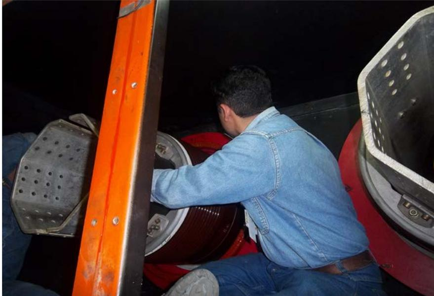
**FIG.4.7.1 Desmontaje de los TC'S de salida del generador**
