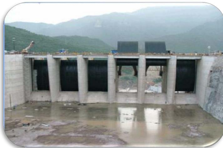
Los tres túneles de descarga del vertedor son de 15 m de diámetro cada uno, 1300 m de longitud, revestidos de concreto y con capacidad normal de
