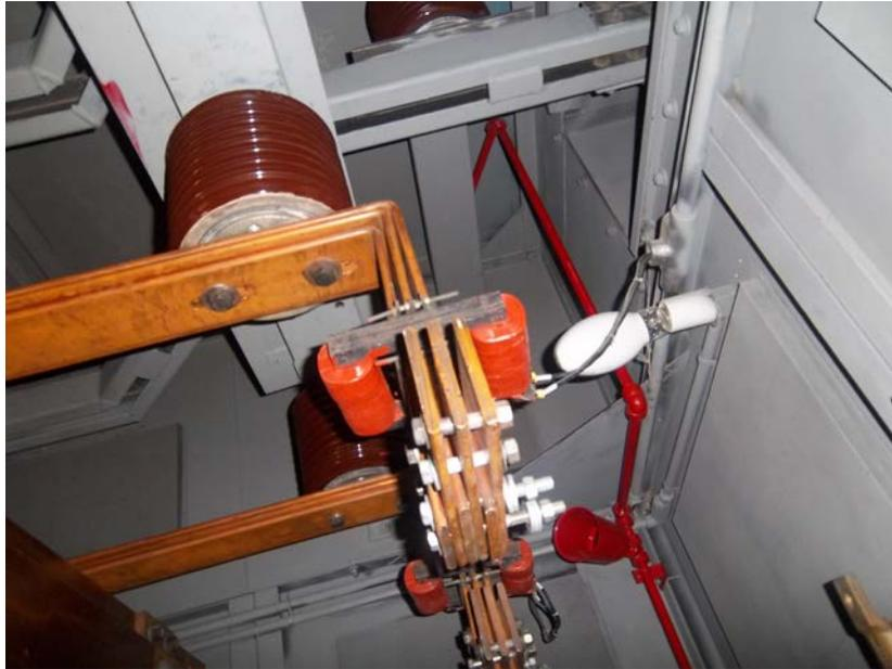
**FIG 4.9.2 Montaje de los TC'S del transformador de excitación**
