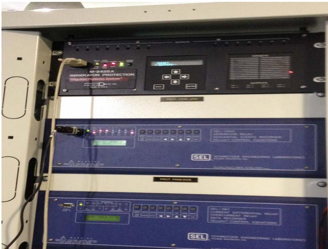
**FIG.3.13.1** CONEXIÓN DE LA PC CON EL SELL PARA ACCEDER CON LAS PROTECCIONES
