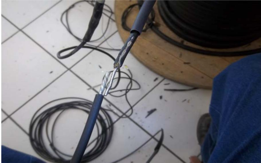
**Fig. 4.2.4 Se comienza a cambiar el cableado de circuitería de las fases de los TC'S dañados.**
