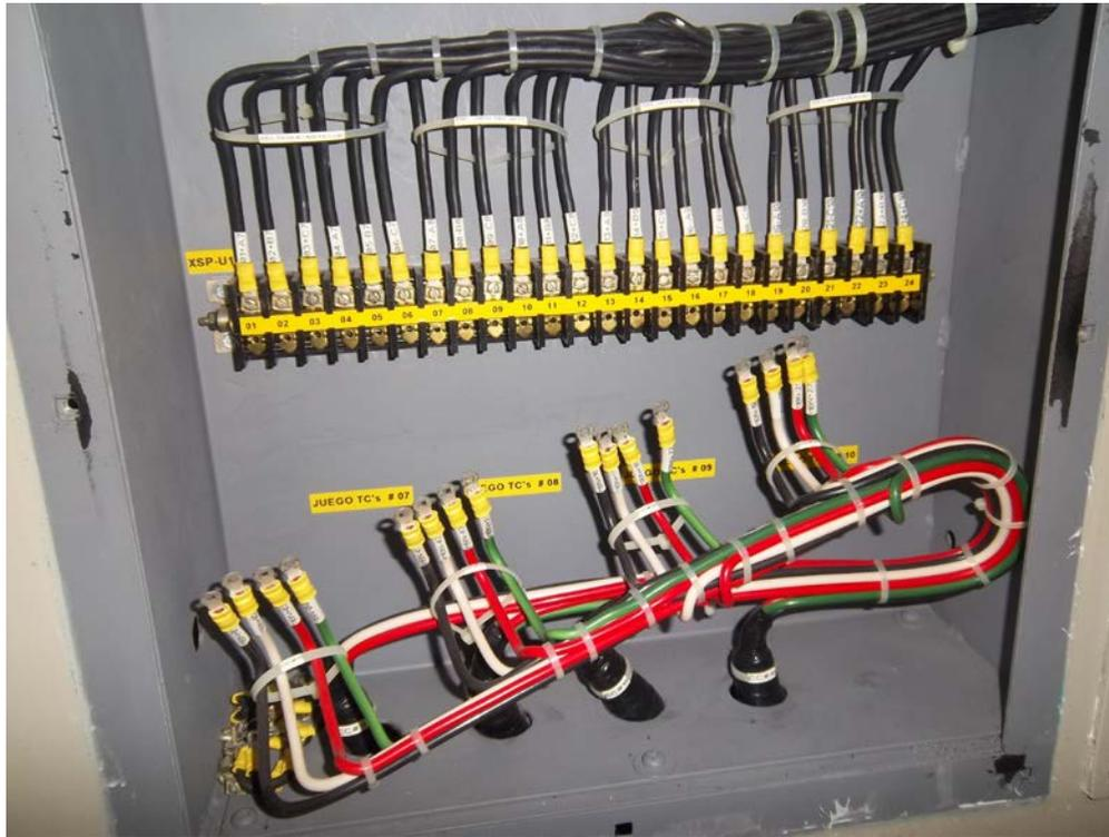
**FIG. 4.10.3 Enzapatado y terminación de la conexión de los cables**
