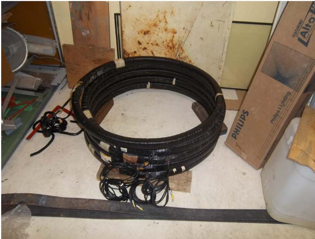
**Fig.4.2.1 Tc's del neutro del generador**
