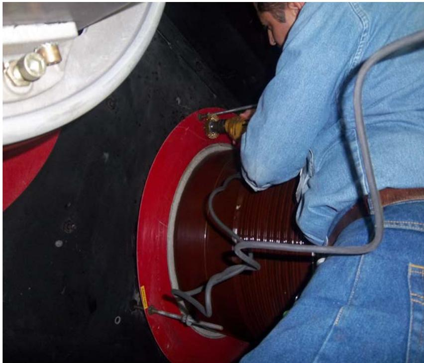
**Fig.4.1 Desmontaje de las fases de los TC'S del neutro del generador**
