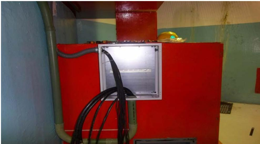
**FIG 4.5.4 Montaje del gabinete y reubicación del cableado**
