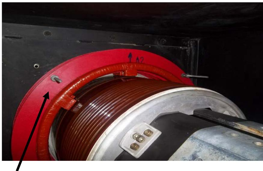
**FIG. 4.5.2 Montaje de los TC'S del neutro del generador**
