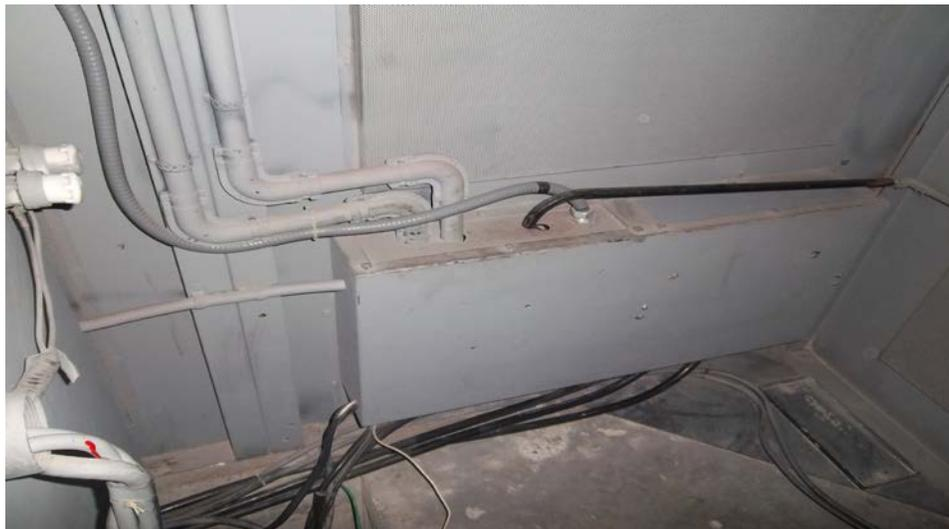
**FIG.4.9.4 Reacomodo del cableado del gabinete**
