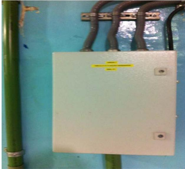
**FIG. 4.8.3 Terminación de colocación final del gabinete de los TC'S de salida del generador**
