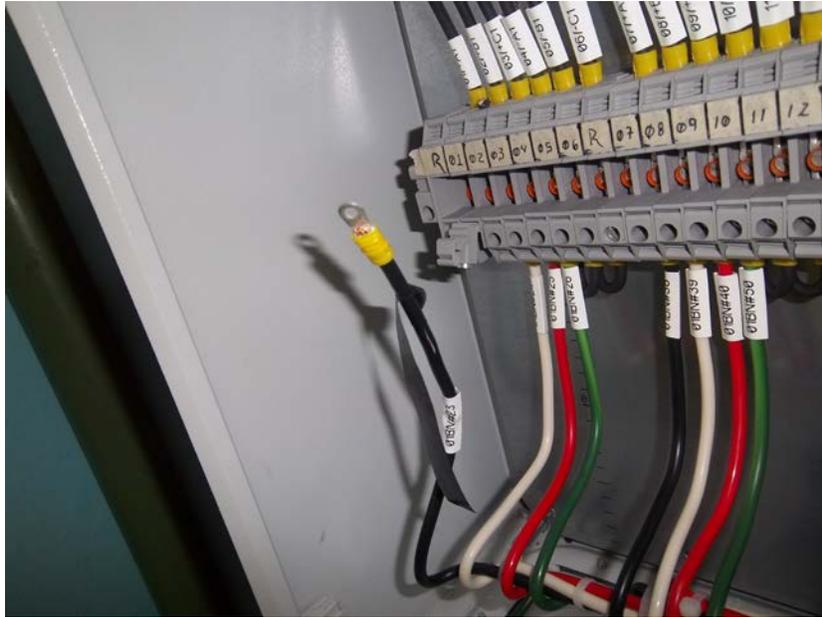
**FIG. 4.8.2 Enzapatado del cableado y colocación alas terminales**
