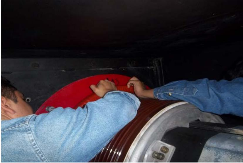
**FIG. 4.7.7 Montaje de los TC'S de salida del generador**
