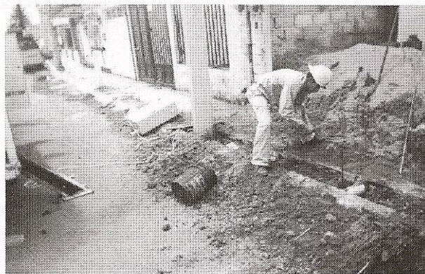
Figura 3.24a Inserción de varilla de cobre en la tierra.
