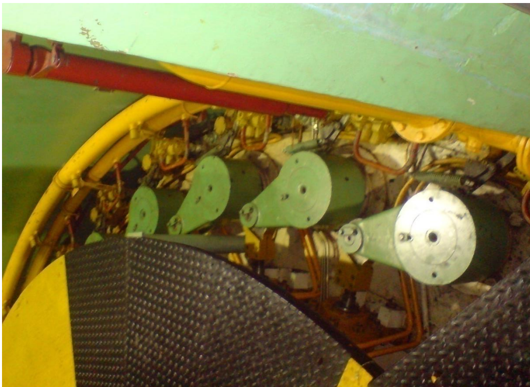
SISTEMA OLEODINAMICO (SERVOMOTORES DE LOS ALABES)
