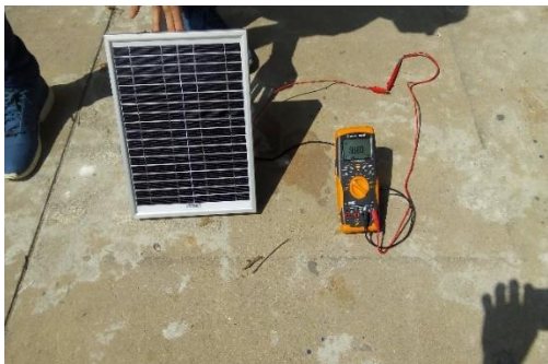
Figura 5.3 Medición de voltaje en circuito abierto del panel = 19.68VDC.
