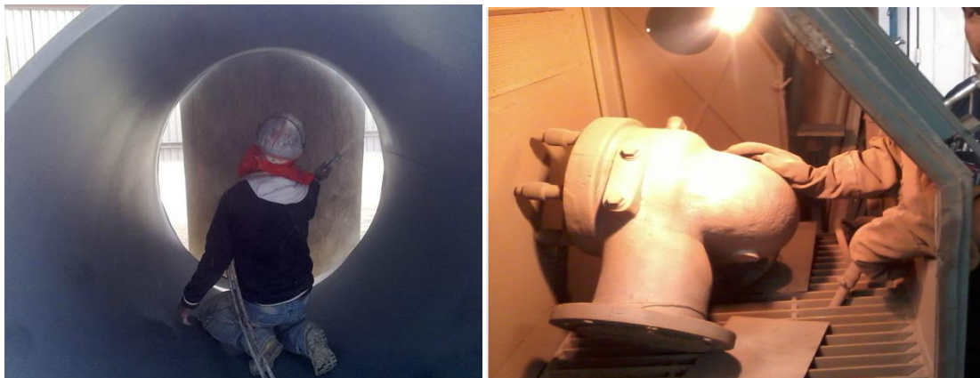
Fig.76 Limpieza SAND BLAST (arena sílica)
