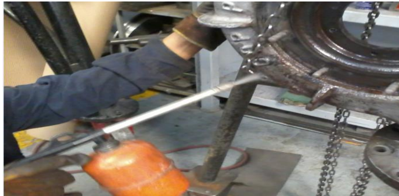
Fig.75 Limpieza pulverización alta presión
