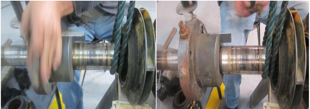
Fig. 56 Desmontaje de sellos mecánicos o prensa estopas
